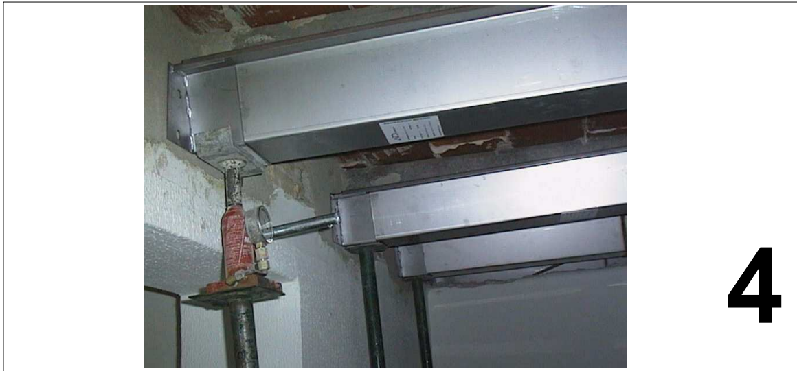
Colocación de los gatos hidráulicos
